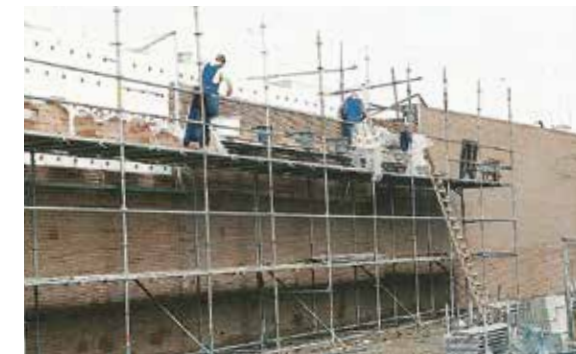
Het metselen van de 'kasteelmuur'
